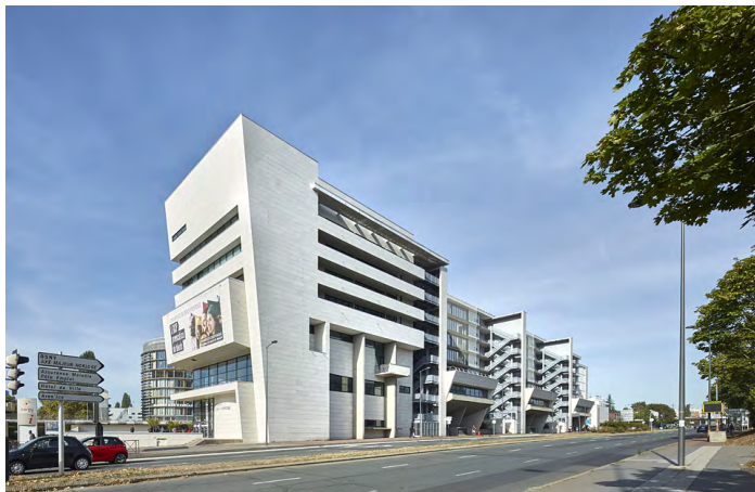
Bâtiment central des Chênes 1
