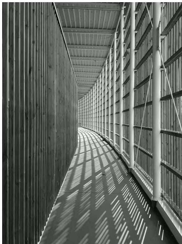
Coursive du gymnase de La Haute Maison
