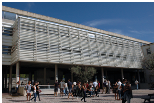
Bibliothèque Universitaire du site Vauban
