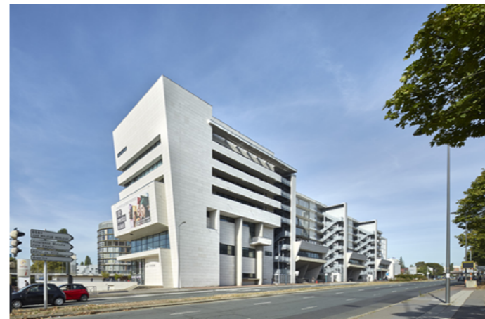
Bâtiment central des Chênes 1
