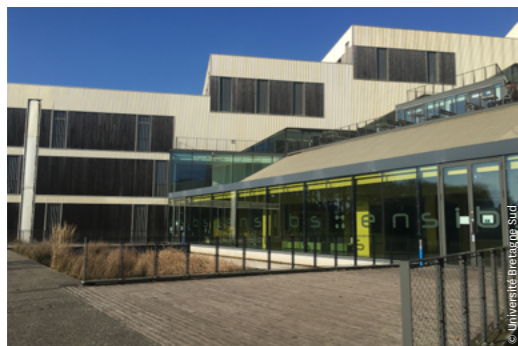
Un bâtiment digne de l'industrie du futur sur le campus de Lorient. L'architecture extérieure est aussi surprenante à l'intérieur.
