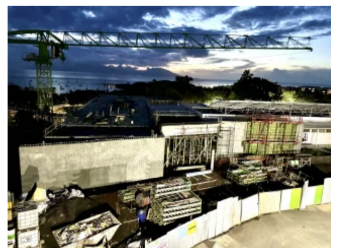
UPF : le chantier de la bibliothèque universitaire en avril 2024 - © MG
