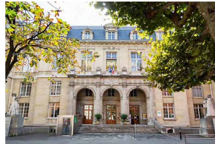
Vue extérieure du bâtiment
