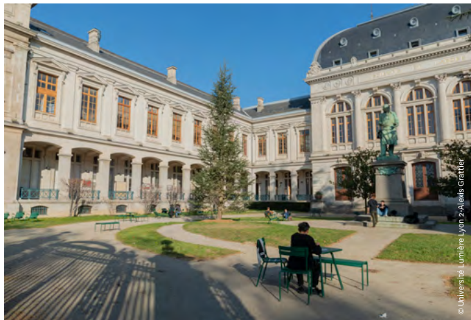
Palais Hirsch, Campus Berges du Rhône
