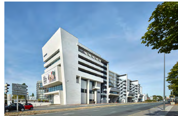
Bâtiment central des Chênes 1
