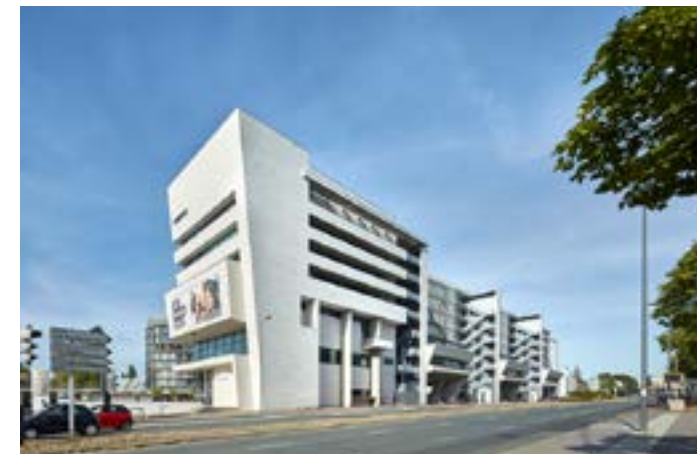
Bâtiment central des Chênes 1
