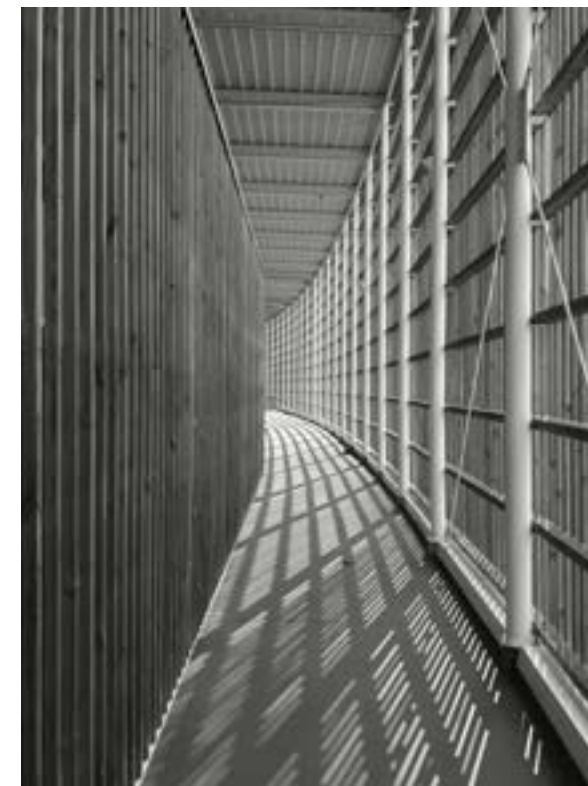
Coursive du gymnase de La Haute Maison
