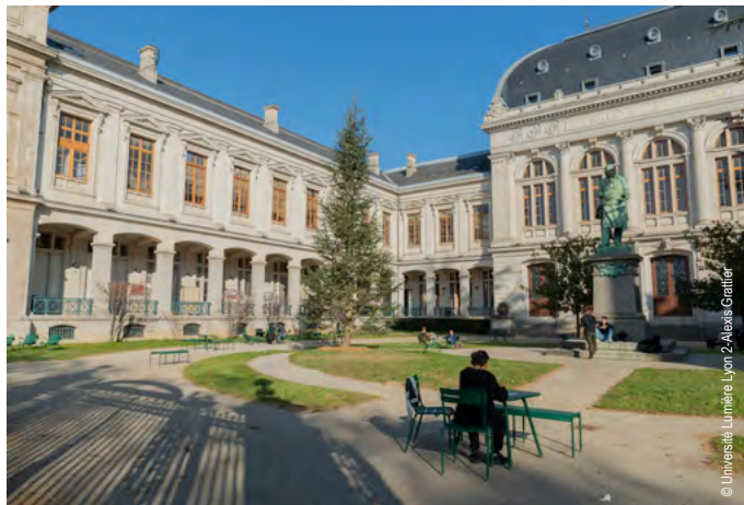
Palais Hirsch, Campus Berges du Rhône
