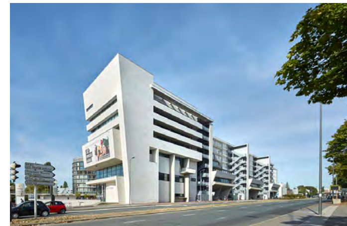
Bâtiment central des Chênes 1
