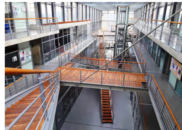
Hall du bâtiment Lavoisier
