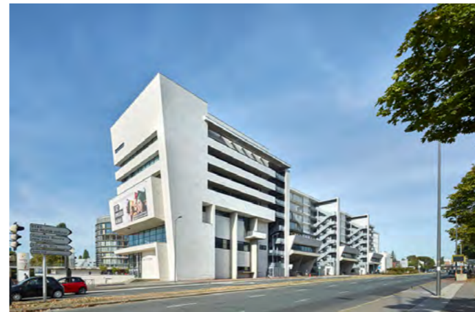
Bâtiment central des Chênes 1
