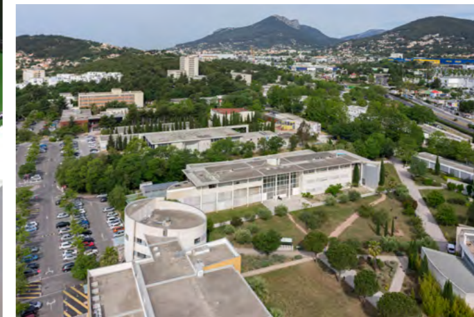
Campus de La Garde, 35 hectares d'espaces et bâtiments variés
