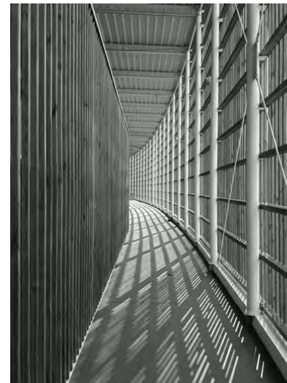
Coursive du gymnase de La Haute Maison
