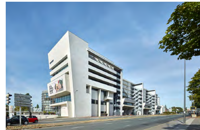
Bâtiment central des Chênes 1
